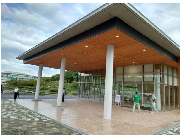
①西口休憩所入口
